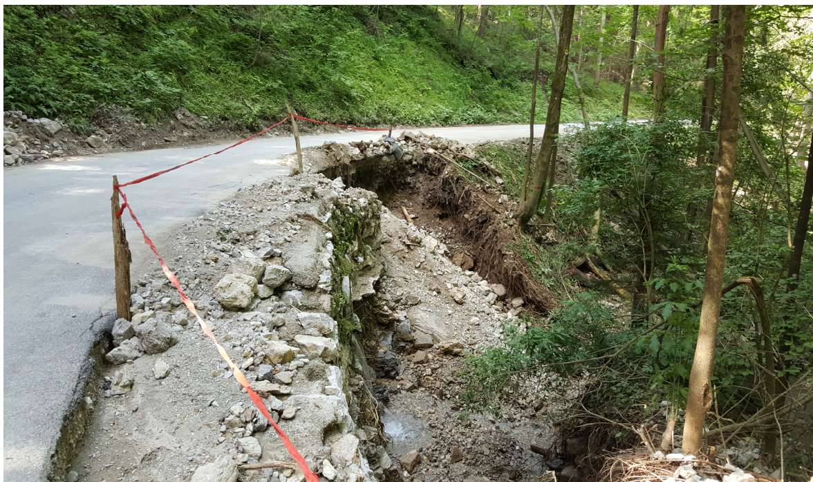
Slika 3: poškodbe na lokalni cesti (vir: Blatnik, A.)
